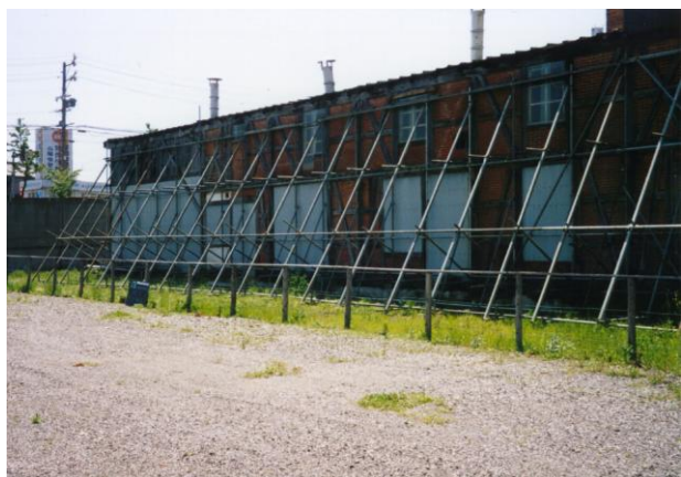
ハーフティンバー部補強工事
